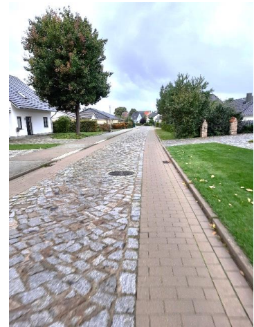
Abbildung 14: Beispiel für Radfahrbereiche auf Fahrbahnen mit Naturpflaster
